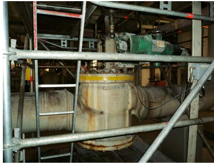
Bild 8: Regelarmatur DN 500 nach einer Betriebszeit von 23 Jahren mit einem Gerüst für die Demontage von Antrieb, Hebelaufsatz, Deckel und Innengarnitur
